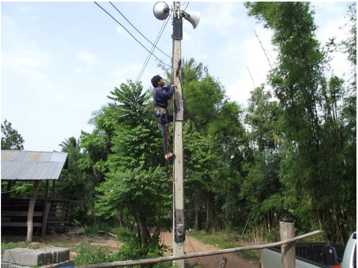
ภาพการติดตั้งเครื่องเสียงไร้สาย ในพื้นที่เสี่ยงภัย หมู่ ๑๓ คุ่มโนนหัวช้าง
