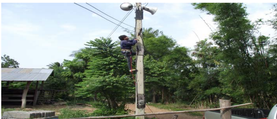
ภาพการติดตั้งเครื่องเสียงไร้สาย ในพื้นที่เสี่ยงภัย หมู่ ๑๓ คุ่มโนนหัวช้าง
